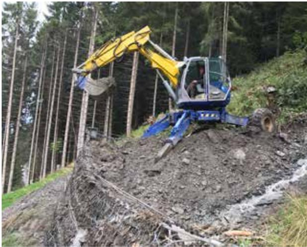
Ein bereits abgeschlossenes Bauvorhaben, das Murauffangnetz oberhalb des neu errichteten Geschiebebeckens „Innerer Eggenbach“ hat im heurigen Sommer die erste Bewährungsprobe gut überstanden. Ca. 30 LKW – Ladungen an Murmaterial sammelten sich im Auffangnetz und im Geschiebebecken an. Diese Menge hätte in jedem Fall eine Totalsperre der Wattentalstraße verursacht.
