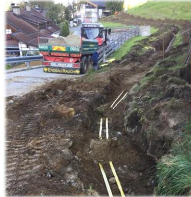
Bei sämtlichen Grabungsarbeiten kooperierten wir mit dem Energieversorger Kraftwerk Haim KG und mit der Telekom A1, um Stromerkabel und Glasfaserleitungen für den Breitbandausbau Zug um Zug mit zu verlegen.
